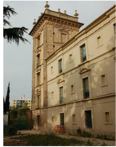
Fachada de levante hacia el parque con ala Laporta a demoler para dar continuidad a las fachadas de cada fase del Museo y para resolver el nuevo acceso desde el parque.
