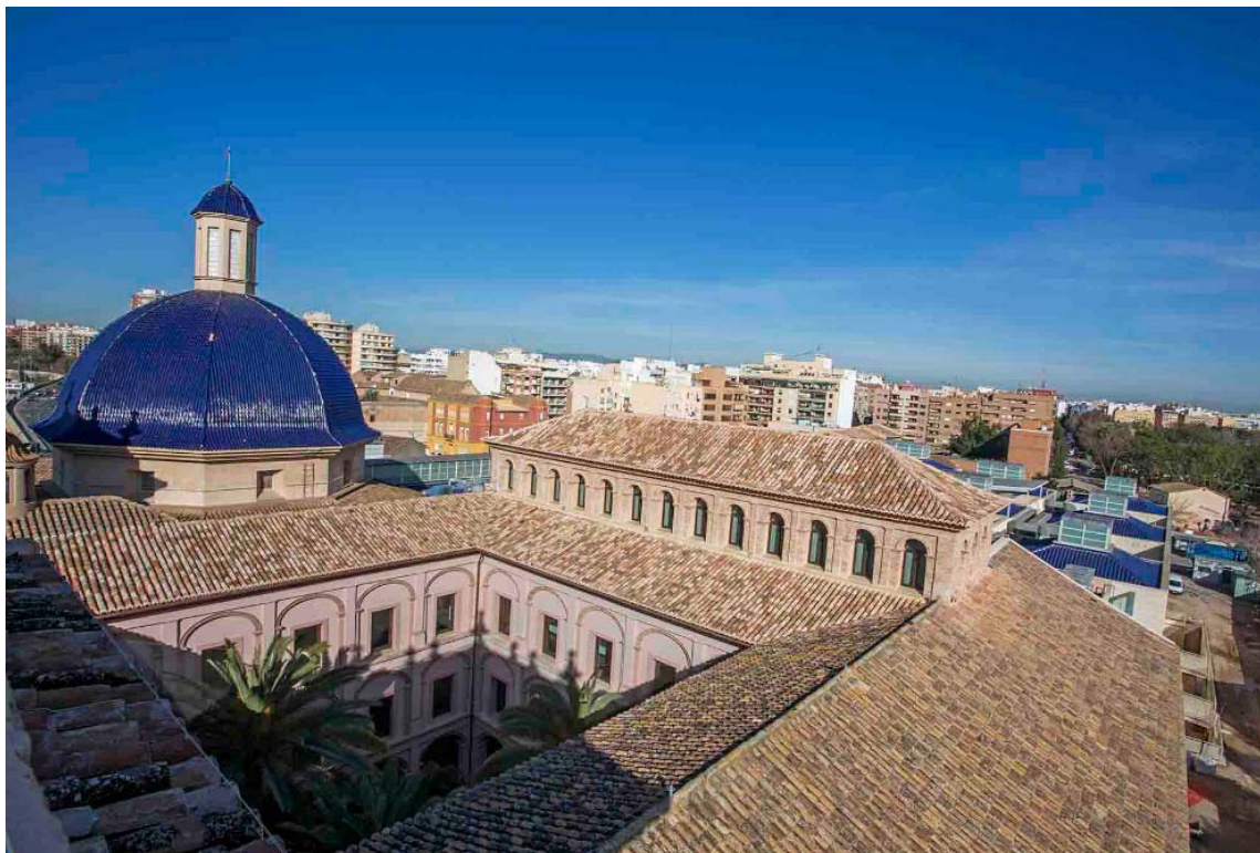
Vista aérea patio central, cúpula y volumen biblioteca.
