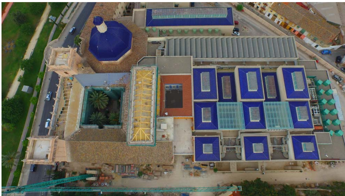
Foto aérea durante los trabajos de cubierta de la V fase, con vistas sobre nuevo núcleo de comunicaciones (en gris), patio Vich (teja roja) y cubiertas (teja vidriada azul) de la IV y parte de la III fase.
