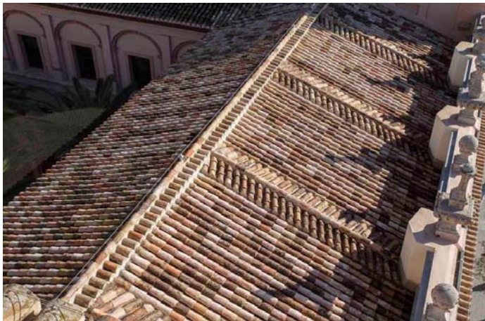
Detalle de cubierta de teja entre Torreones.
