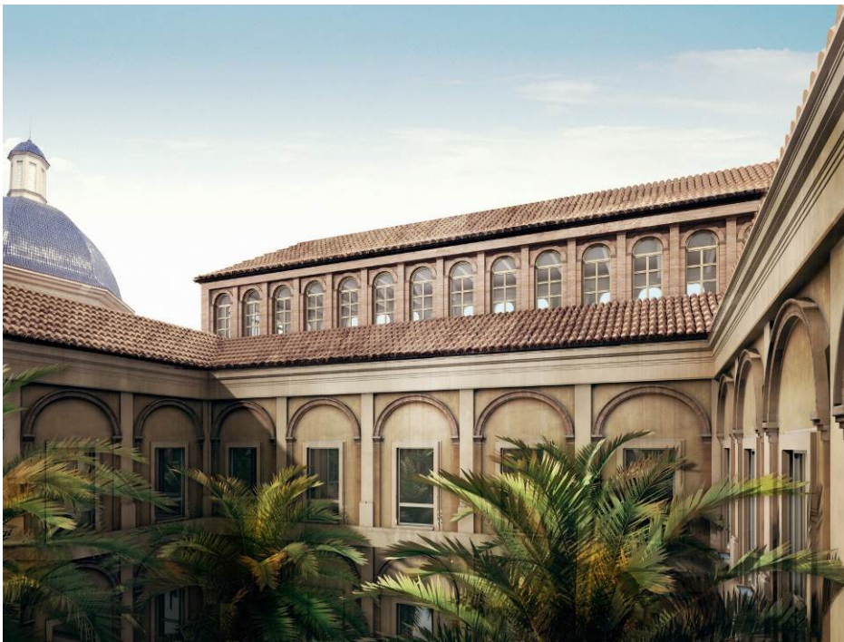
Interior del Claustro rematado por el Coloseo.
