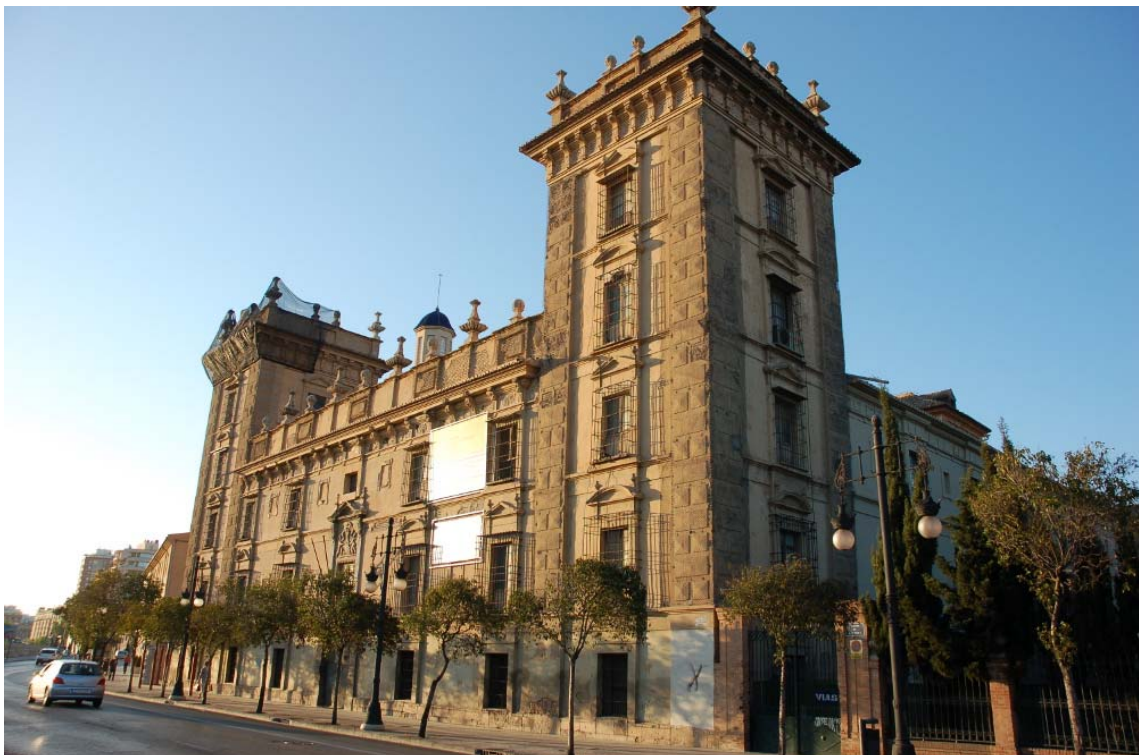
Fachada principal sur con torreones enmallados para evitar desprendimientos; con numerosos problemas de conservación e identidad.
