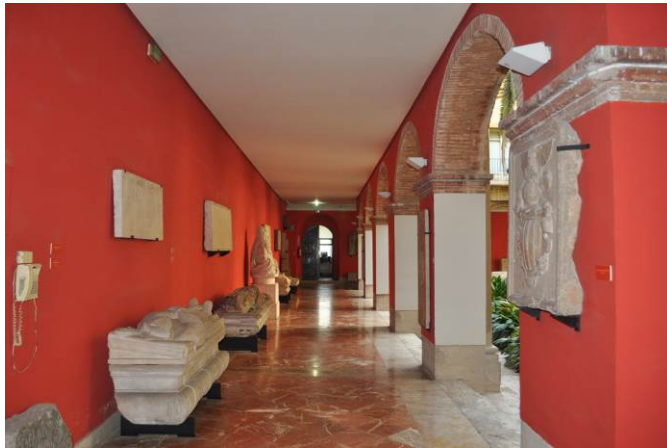
Laterales del claustro con descontrol en tendidos de instalaciones
