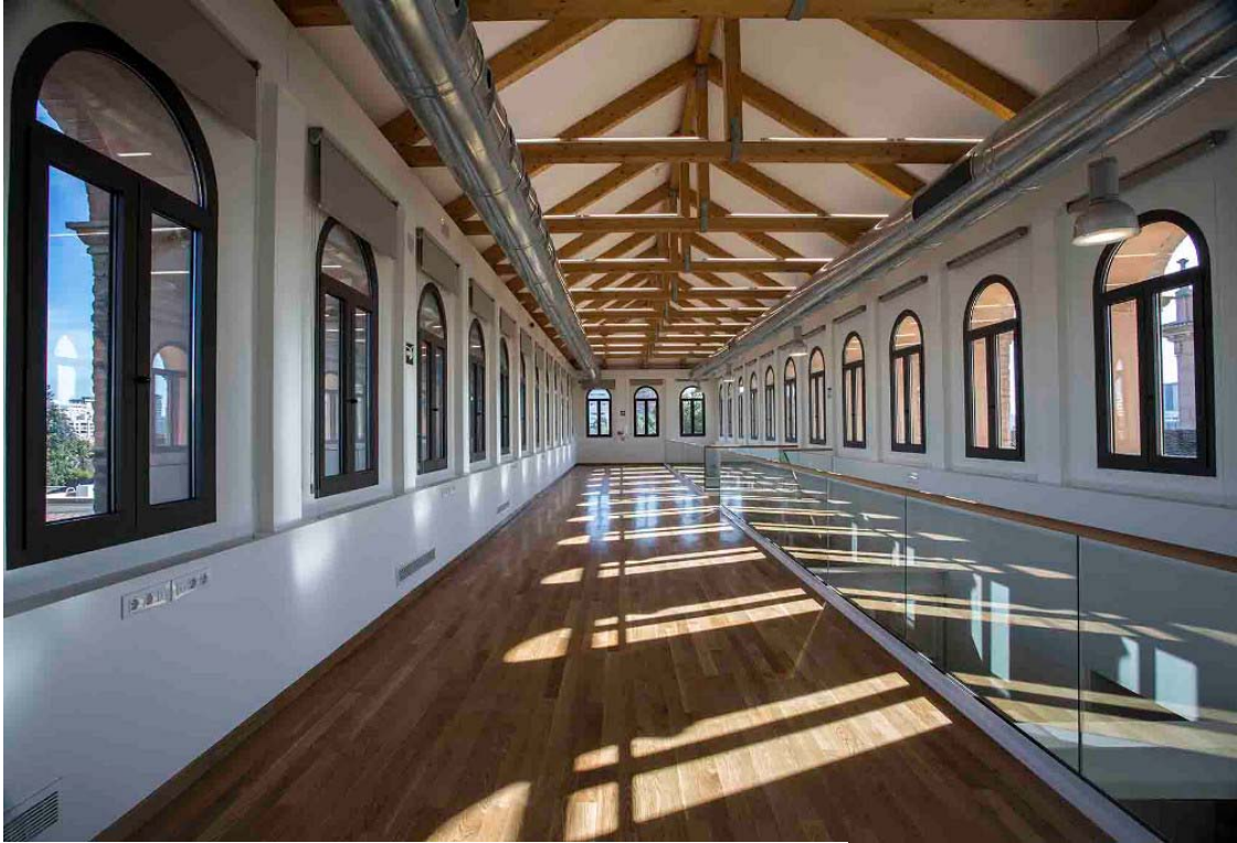
Nueva Biblioteca, vista general de las cerchas.
